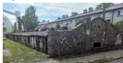
Fot. 4a. Sklepione piwnice, kryte papą; źródło: archiwum auterek, sierpień 2023
