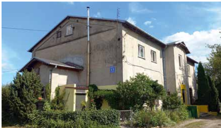
Fot. 8. Budynek ambulatorium, ul. Działkowa 11; źródło: archiwum autorek, sierpień 2023
