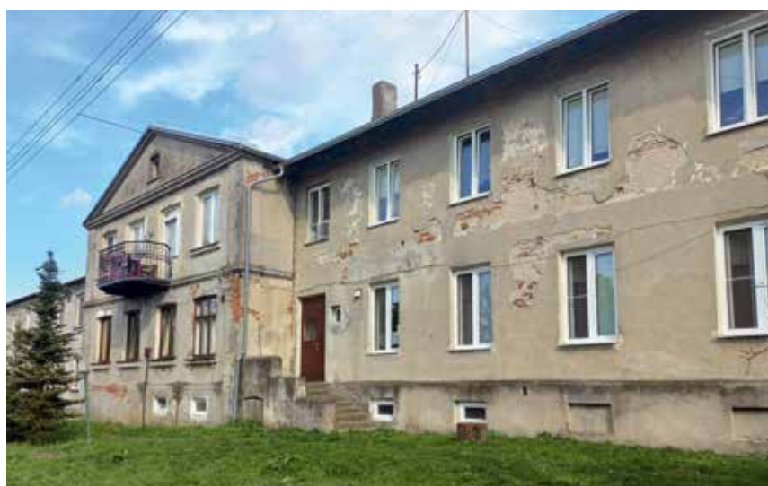
Fot. 7. Budynek mieszkalny „Cytadela”, ul. W. Jagiełły 89; źródło: archiwum autorek, sierpień 2023
