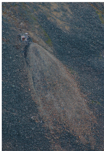
Ryc. 7. Ogólny widok sztolni G2b–C: zabudowany wlot wyrobiska, niewielkie zapadlisko powyżej oraz hałda Fig. 7. General view on adit no. G2b–C: entrance of adit, small depression above and waste dump
