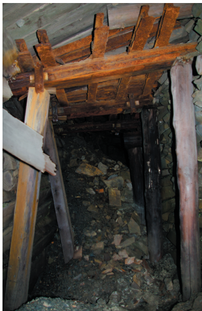
Ryc. 4. Wnętrze sztolni nr G2b- \alpha z dobrze widocznym sposobem zabezpieczenia ociosów i stropu
