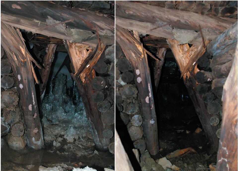
Ryc. 2. Końcowa część dostępnego odcinka sztolni G1b-β na fotografiach z lat 2012 (po lewej) i 2015 (po prawej), widoczne drobne różnice w stanie zachowania obudowy oraz rozwój kolonii grzybów na belkach obudowy
