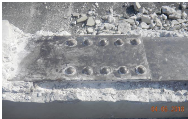
Rys. 9. Odkrywka połączenia montażowego na zakład pasów górnych rygla i słupa z widocznym nitowaniem, potwierdzająca zgodność z projektem widocznym na rysunku 5
