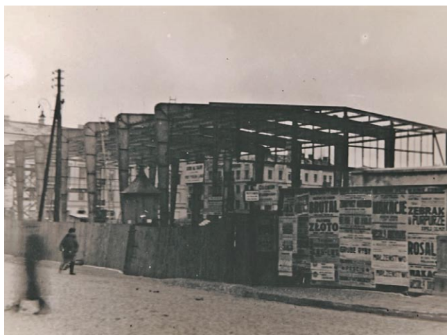
Rys. 2. Fotografie z realizacji budowy: widok zmontowanej konstrukcji ram stalowych od strony południowej (z lewej) i południowo-zachodniej (z prawej); od spodu rygli widoczne belki stalowe stropodachu [1]
