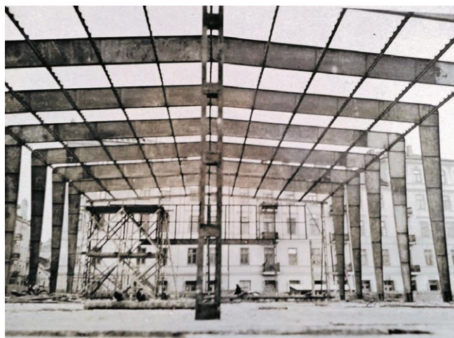
Rys. 2. Fotografie z realizacji budowy: widok zmontowanej konstrukcji ram stalowych od strony południowej (z lewej) i południowo-zachodniej (z prawej); od spodu rygli widoczne belki stalowe stropodachu [1]
