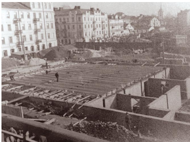
Rys. 1. Fotografie z realizacji budowy: wykonywanie stropu nad piwnicą i przybudówek handlowych (po lewej) oraz prace montażowe przy konstrukcji ram stalowych (po prawej) [1]
