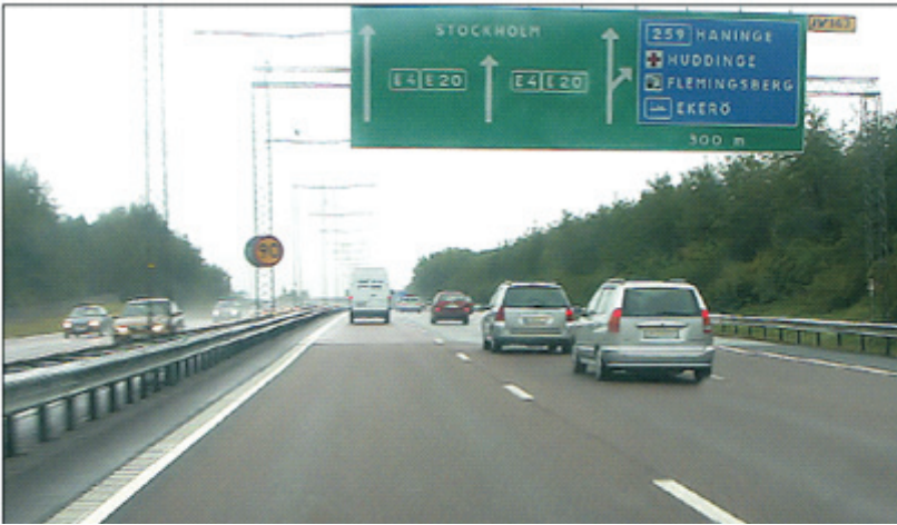
Rys. 4.1. Szwecja, podwójna warstwa nawierzchni porowatej (dwa lata eksploatacji) na autostradzie E4 na południowy zachód od Sztokholmu podczas jazdy w deszczową pogodę, odwodnienie liniowe przy krawędzi jezdni — brak charakterystycznej mgiełki za pojazdami
