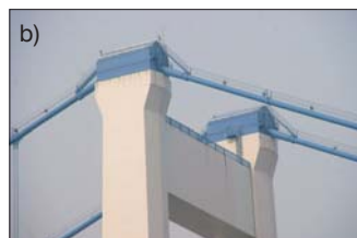
Fot. 57. Most Jiangyin – siódmy w świecie: a) widok od strony parku, b) szczegół oparcia lin na pylonie, c) przekrój liny niosącej
