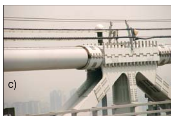
Fot. 55. Most Runyang – piąty w świecie: a) widok z wału na lewym brzegu rzeki, b) widok z pomostu na pylon, c) połączenie kabla z pomostem w środku rozpiętości przęsła
