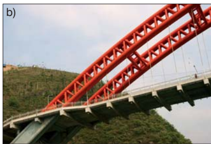
Fot. 39. Most Dragon Gate przy ujściu Daning do Jangcy: a) widok ogólny, b) szczegół
