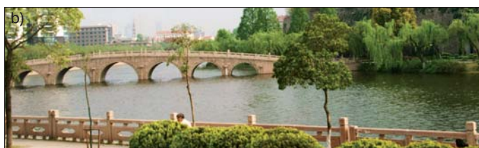
Fot. 50. Miejskie mosty kamienne w Nankinie: a) wiadukt z łukami pachwinowymi, b) most na kanale
