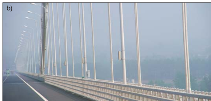
Fot. 54. Czwarty Most Nankiński – szósty w świecie: a) widok z oddali, b) fragment pomostu z wieszakami
