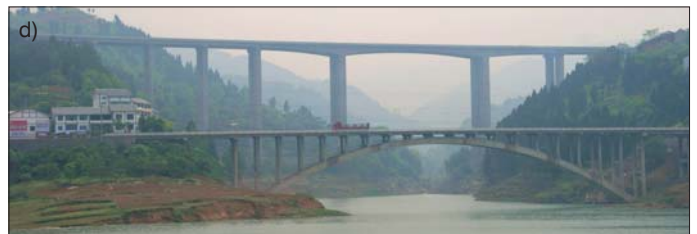
Fot. 34. Kilka mostów przy ujściach rzek do Jangcy: a) typowy most z 4 łukami w przekroju i zastrzałowym podparciem pomostu, b) most łukowy z zatopionymi węzłowaniami, c) most łukowy z pionowymi słupkami, d) most łukowy z pionowymi słupkami, na tle wysokiego mostu belkowego z betonu sprężonego
