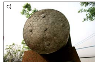
Fot. 57. Most Jiangyin – siódmy w świecie: a) widok od strony parku, b) szczegół oparcia lin na pylonie, c) przekrój liny niosącej
