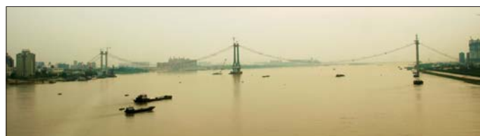
Fot. 47. Budowa mostu Yingwuzhou – widok z pomostu mostu z 1957 r
