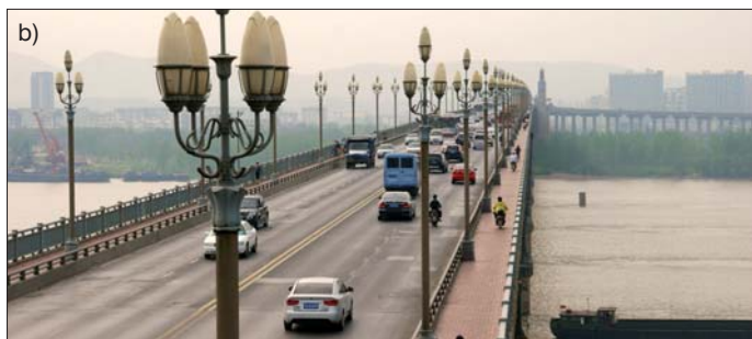
Fot. 49. Most kratowy drogowo-kolejowy w Nankinie z 1968 r.: a) widok z brzegu rzeki, b) widok pomostu drogowego z wieży przyczółka
