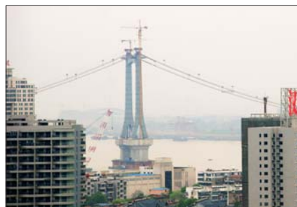
Fot. 48. Budowa pylonu mostu Yingwuzhou – widok z Pagody Żółtego Żurawia
