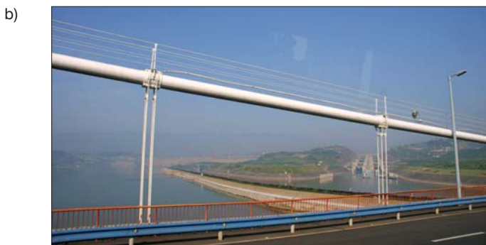
Fot. 42. Most Xiling po drugiej stronie Tamy Trzech Przełomów: a) widok od strony Tamy, b) szczegół liny nośnej i zamocowania wieszaków (w oddali widoczne śluzy)
