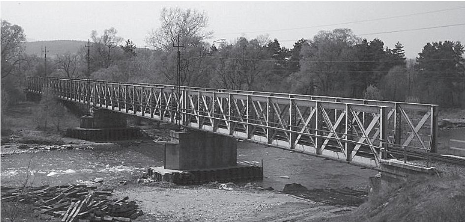
Fot. 3. Most na Popradzie pod Starym Sączem
