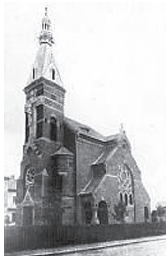
Fot. 13. Kościół kolejowy w 1930 roku
