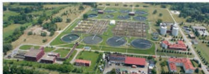
Oczyszczalnia Ścieków „Kujawy”
