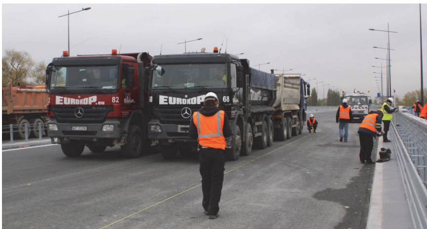
Rys. 10. Obciążenie próbne. Przykład ustawiania obciążenia przęsła 4–5
