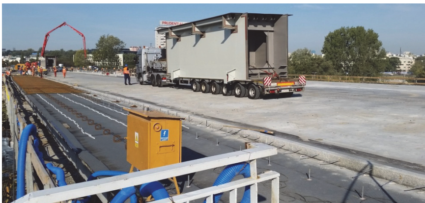
Rys. 9. Próbné obciążenie techniczne. Pojazd obciążający nad przęsłem 6–7 ustawiony w kierunku osi podpory nr 6
