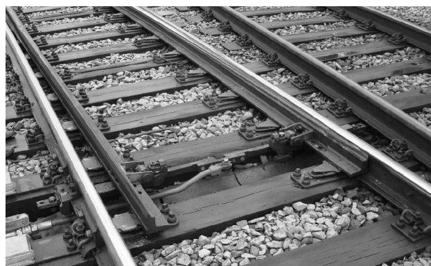
Rys. 2. Zespół zwrotnicy rozjazdu zwyczajnego [fot. M. Czarnecki]
