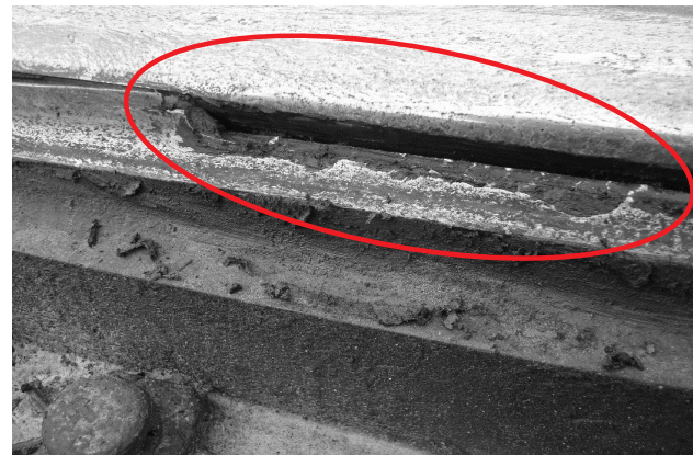
Rys. 3. Uszkodzenia iglic w postaci wykruszenia materiału: a) iglica rozjazdu 3, b) iglica rozjazdu 1 [fot. M. Czarnecki]
