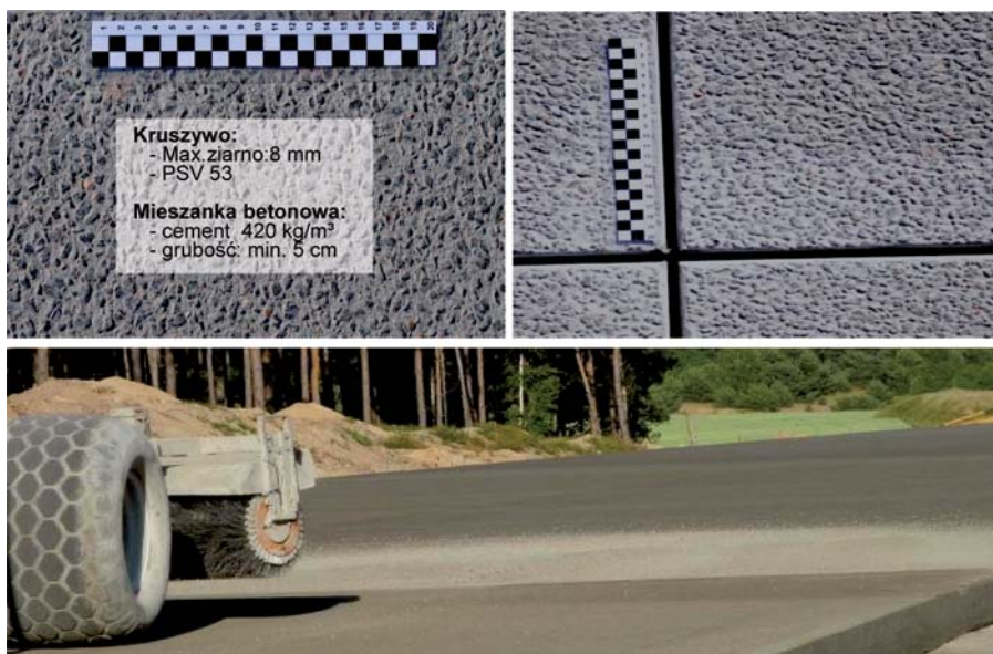
Fot. 4. Przykład nawierzchni w technologii odkrytego kruszywa realizowanej na autostradzie A2 w Polsce
