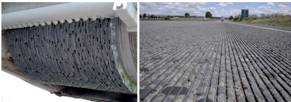
Fot. 3. Rowkowanie i szlifowanie diamentowe ( diamond grinding and grooving ), [7]
