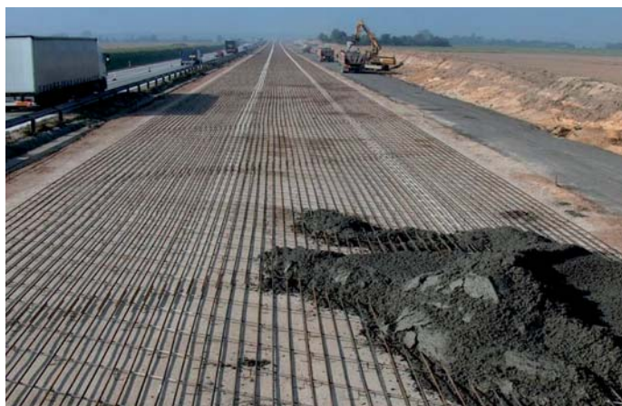
Fot. 2. Układ zbrojenia przy budowie autostrady A4
