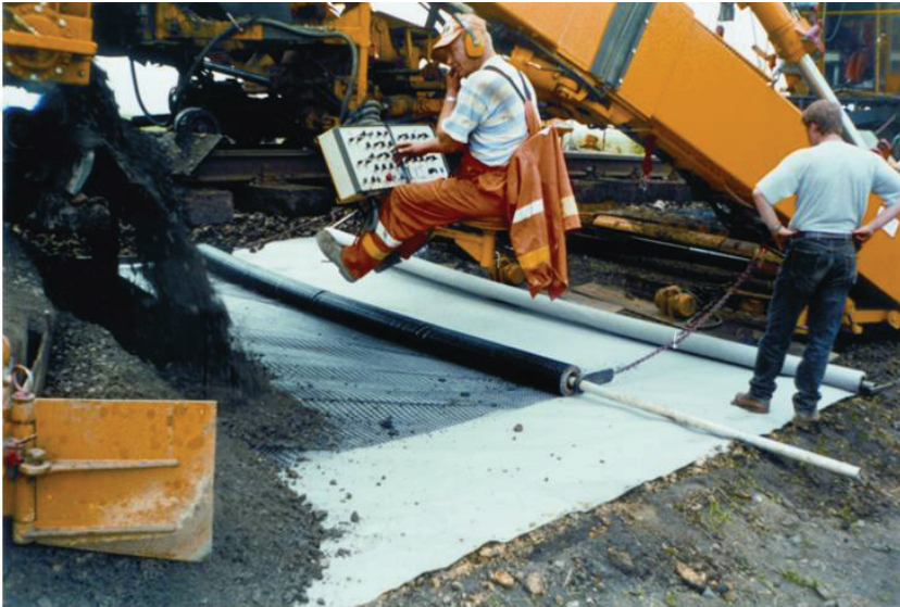
Fot. 4. Modernizacja podbudowy torowiska linii kolejowej E30 Lewin Brzeski – Łosiów w celu dostosowania linii kolejowej do prędkości 160 km/h – Fibertex® F-650M i Fortrac® 80/80-30, 2000r.
