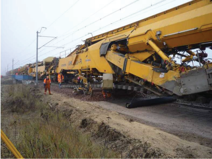
Fot. 5. Rewitalizacja Linii Kolejowej CMK, Fortrac® 80/80-30, 2008r. Fot. P. R. INORA sp. z o.o.
