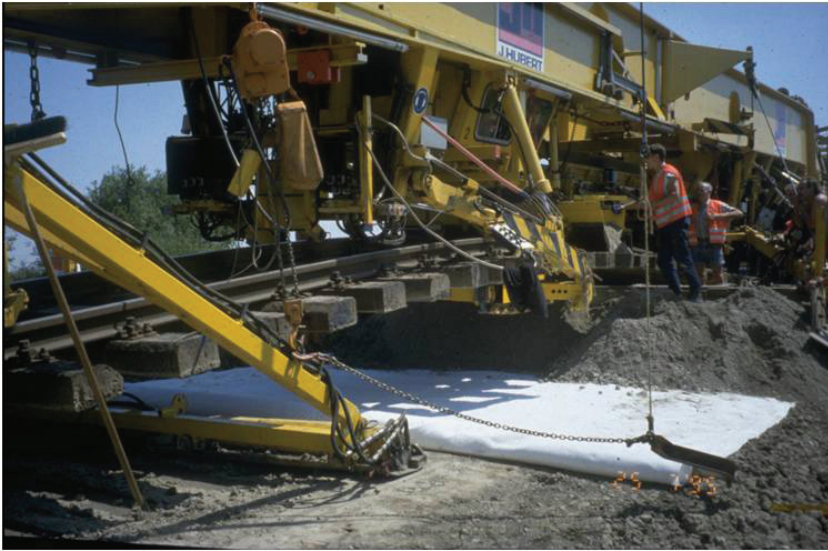
Fot. 3. Linia kolejowa Münster - Hamm w trakcie rewitalizacji, kompozyt Comtrac® 55/50 B30, 1995 r.
