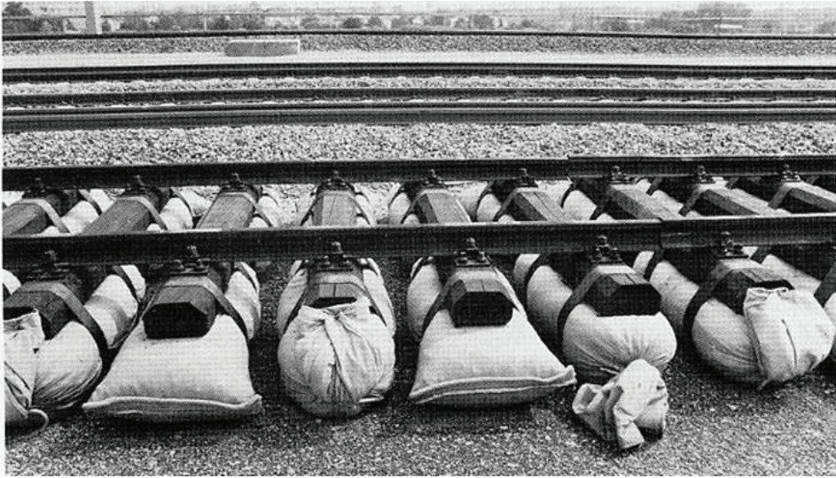
Fot. 2. Worki z geotkaniny wypełnione tłuczniem i podpięte pod podkłady kolejowe za pomocą taśm z poliestru (van Sandvoort 1994)
