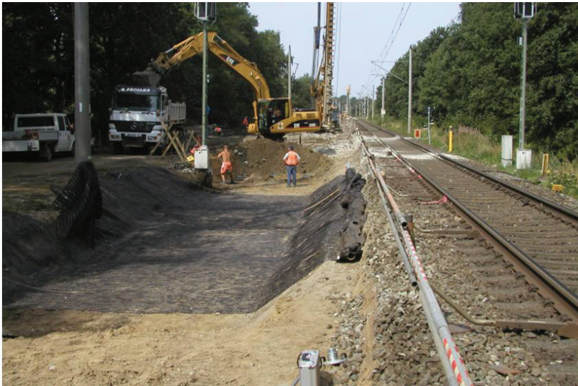
Fot. 8. Instalacja poprzecznego zbrojenia nadpalowego na pierwszej półtorze w podtorzu, Linia Kolejowa Berlin-Hamburg, odcinek „Büchen”
