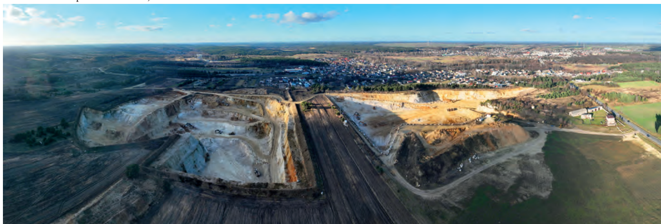
Rys. 5. Eksploatacja złóż wapieni zalesiackich Raciszyn – pole S i pole N (Źródło: WKG Sp. z o.o.)
