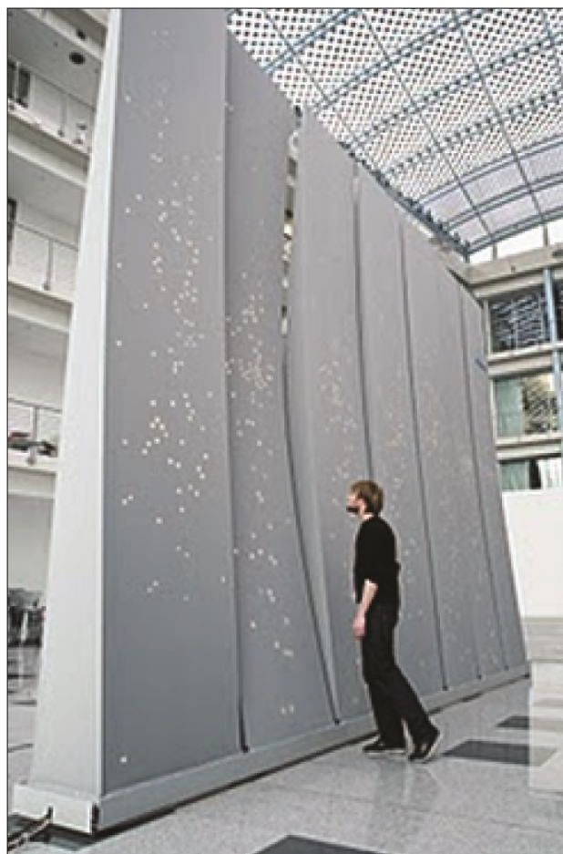
12. Interactive Wall, Hyperbody, TUD, 2009 r., copyright Festo AG – interaktywność jest tu zastosowana we fragmentach budynku, które wprowadzane są w ruch, odpowiadając na warunki środowiskowe i potrzeby użytkownika; elementy interaktywne zmieniają swoją geometrię za sprawą wbudowanych czujników i siłowników pneumatycznych FESTO
