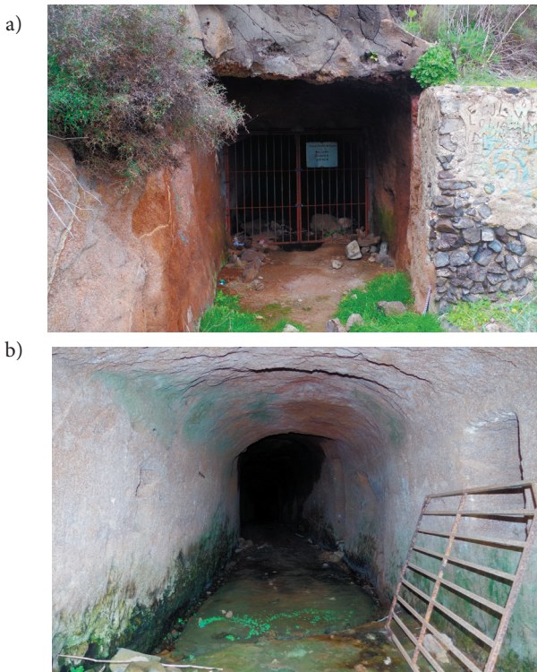
Ryc. 5. Sztolnia w Barranco del Chafariz; a) wlot wyrobiska drążonego w pokładzie tufu, w stropie widoczny bazalt, b) wstępny odcinek sztolni
