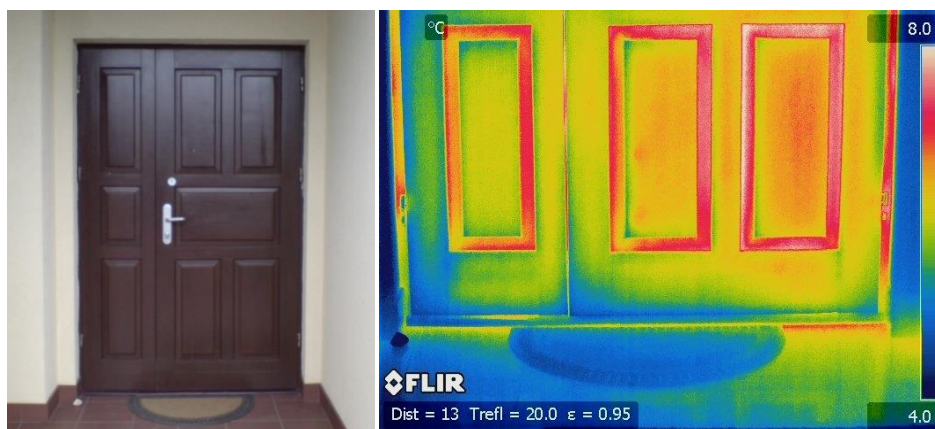
Rys. 2. Elewacja zachodnia budynku – termogram nr 1
