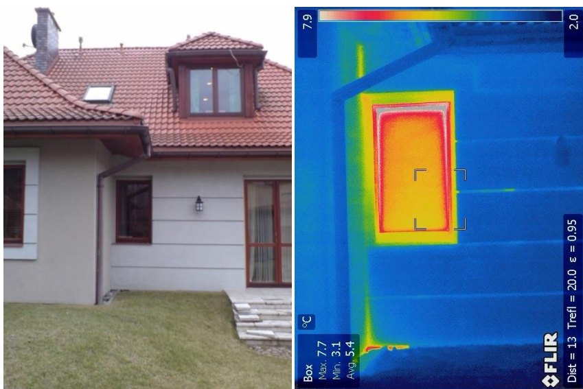
Rys. 8. Elewacja wschodnia budynku – termogram nr 7
