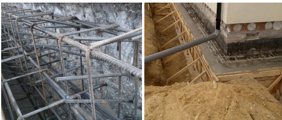
Rys. 7. Główne etapy wykonywania wzmocnienia łąw fundamentowych [6]: po lewej: zbrojenie obwodowe łąwy, po prawej: przerwa technologiczna w trakcie prac żelbetowych
