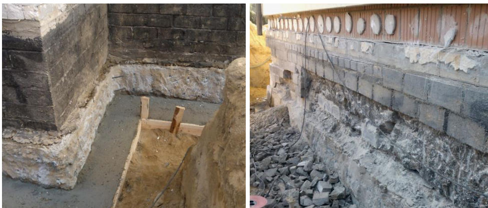
Rys. 6. Początkowe etapy wykonywania wzmocnienia łąw fundamentowych [6]: po lewej: nowa łąwa z betonu C12/15, po prawej: skute elementy muru fundamentowego z betonitów niskiej jakości
