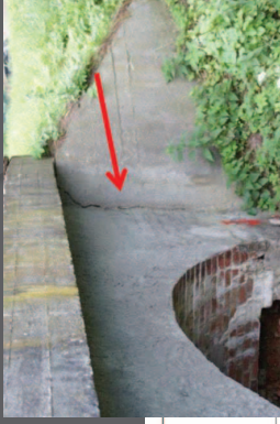
Wycieszczenie gzymśców obróbką strumieniowo-ciełną
