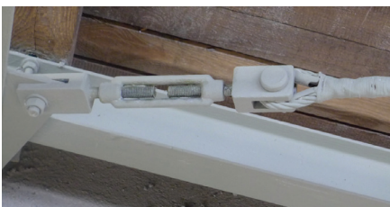
Rys. 5. Śruba rzymska do regulacji napięcia
