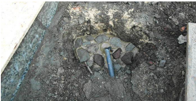
Rys. 5. Widok punktu pomiarowego po instalacji przed położeniem płyty
