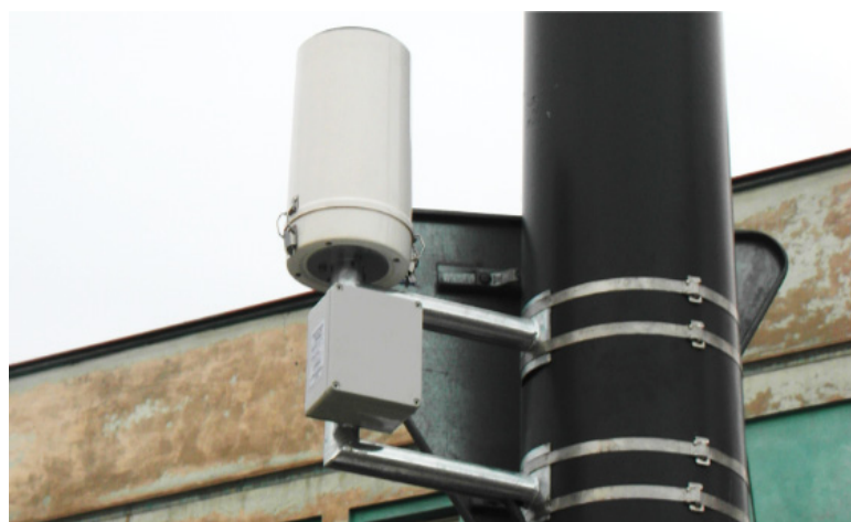
Rys. 6. Widok deszczomierza przymocowanego do słupa po instalacji
