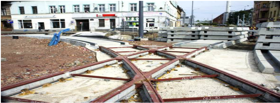
Rys. 1. Widok nawierzchni w strefie przejazdu
