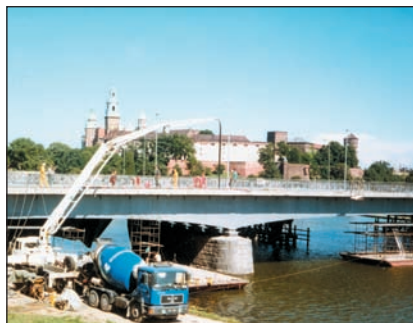
Naprawa mostu Dębnickiego
