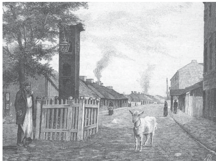
Rys. 5. Ulica Smocza w Warszawie z nową nawierzchnią z kamienia z wydzielonymi chodnikami. E. Perle („Kłosa” z 1886 r.) [1]
