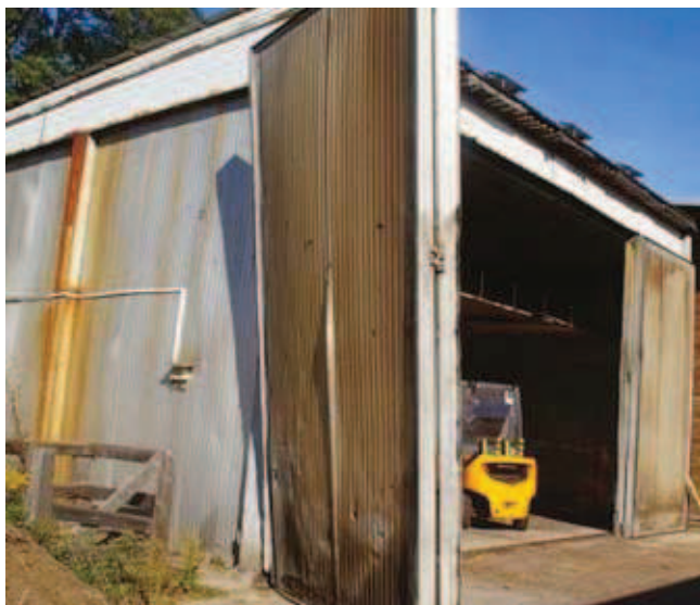
Rys. 5. Wypaczone drzwi wejściowe do komory suszarniczej będące przyczyną nieszczelności
