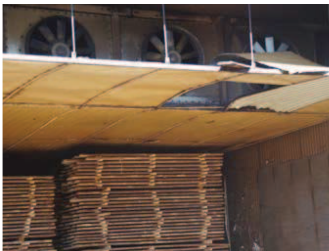
Rys. 2. Rozwój korozji w miejscach uszkodzeń, połączeń oraz podłączenia czujników wilgotności
