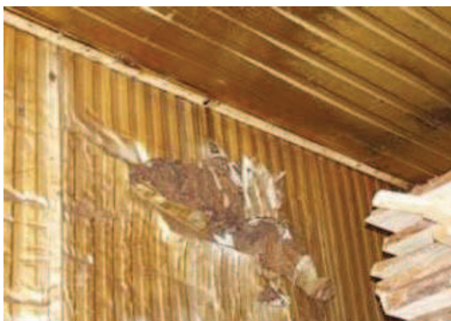
Rys. 6. Uszkodzenia widoczne na wewnętrznej powierzchni ścian komory suszarniczej
