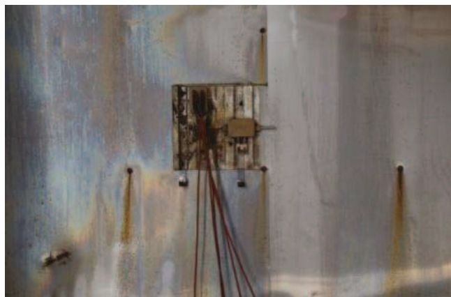
Rys. 7. Rozwój korozji w miejscach uszkodzeń, połączeń oraz podłączenia czujników wilgotności
