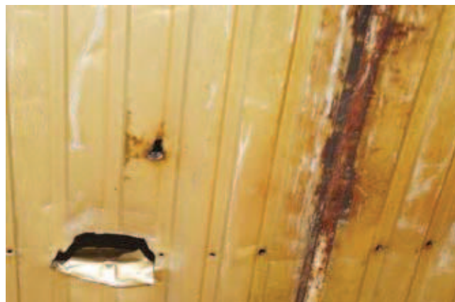
Rys. 7. Rozwój korozji w miejscach uszkodzeń, połączeń oraz podłączenia czujników wilgotności
