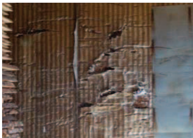
Rys. 6. Uszkodzenia widoczne na wewnętrznej powierzchni ścian komory suszarniczej
