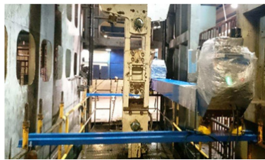
Fig. 17. Setup the Mobile Laser Scanning System in the shaft cage before measuring (SKALA 3D) Rys. 17. Ustaw mobilny laserowy system skanujący w klatce szybu przed pomiarem (SKALA 3D)
