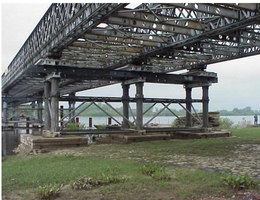
Rys. 1.4. Podpora pośrednia na płytach żelbetowych
