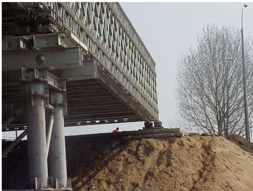
Rys. 1.3. Podparcie na przyczółku wykonane z płyt betonowych
