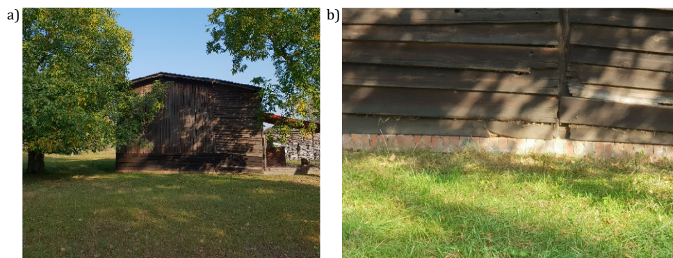
Rys. 1. Widok rozważanego magazynu: a) elewacja frontowa; b) fundament
