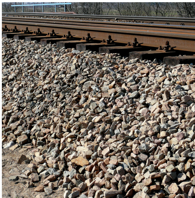
Rys. 6. Tor rok po wymianie ciągłej, grubość warstwy podsypki zbliżona do 1 m, w górnej części czoła podkładów odśnieżone do połowy, okienka wypełnione do połowy wysokości podkładów
