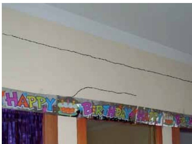
Rys. 5. Widok osiadania posadzki i zarysowania ścianek działowych w pomieszczeniach mieszkalnych nad garażem w budynku nr 36C
