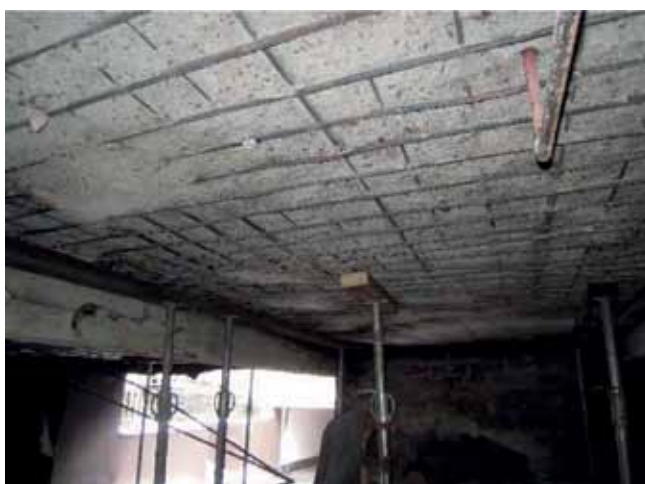
Rys. 4. Widok uszkodzeń konstrukcji żelbetowej i ścian murowanych w garażu budynku nr 36C
