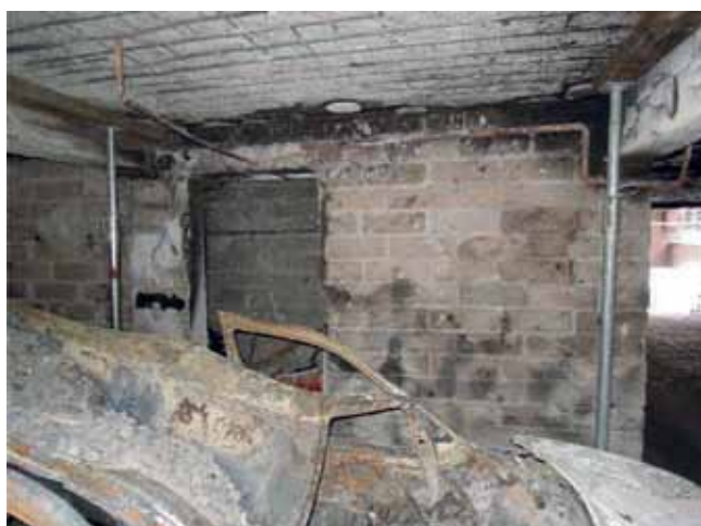
Rys. 4. Widok uszkodzeń konstrukcji żelbetowej i ścian murowanych w garażu budynku nr 36C
