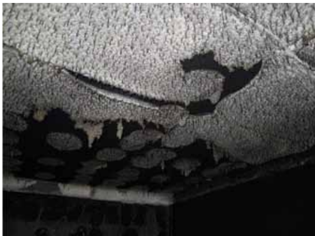
Rys. 2. Widok wnętrza garażu pod budynkiem nr 36B, z widocznym roztopionym styropianem
