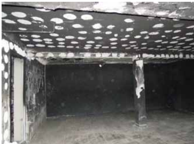
Rys. 2. Widok wnętrza garażu pod budynkiem nr 36B, z widocznym roztopionym styropianem
