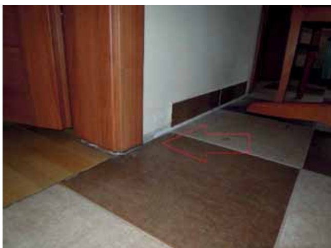
Rys. 5. Widok osiadania posadzki i zarysowania ścianek działowych w pomieszczeniach mieszkalnych nad garażem w budynku nr 36C
