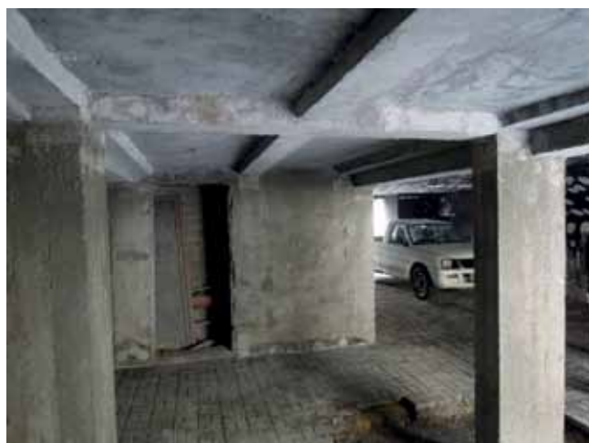
Rys. 12. Widok wykonanego wzmocnienia konstrukcji, z dodatkowymi słupami żelbetowymi i rusztem z obetonowanymi belkami stalowymi
