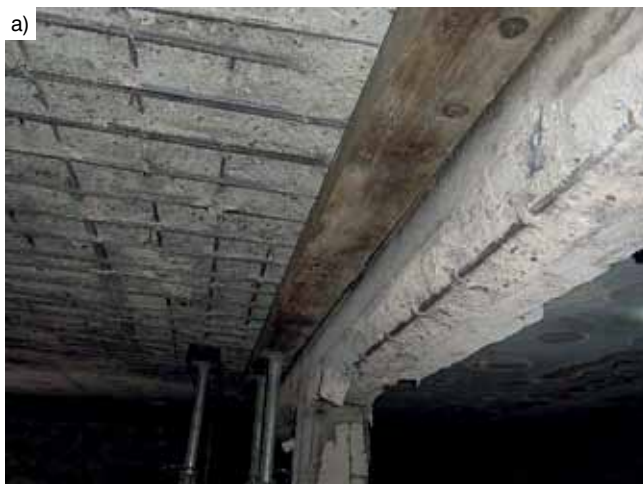
Rys. 8. Widok uszkodzeń konstrukcji żelbetowej w garażu budynku nr 36C, z odsloniętym zbrojeniem: a – płyta i belka, b – słup
