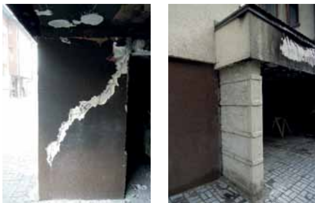
Rys. 13. Widok uszkodzonej ściany i jej wzmocnienie obejmami stalowymi
