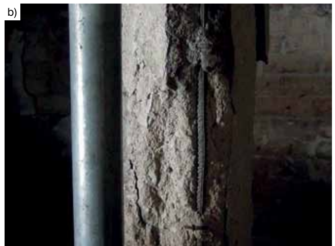
Rys. 8. Widok uszkodzeń konstrukcji żelbetowej w garażu budynku nr 36C, z odsloniętym zbrojeniem: a – płyta i belka, b – słup
