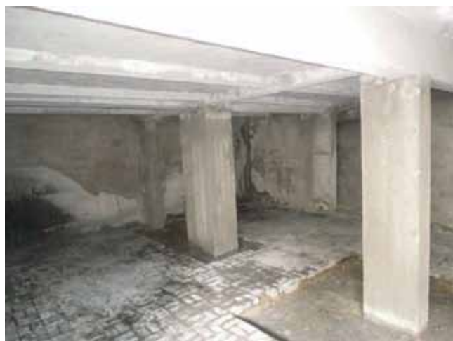
Rys. 12. Widok wykonanego wzmocnienia konstrukcji, z dodatkowymi słupami żelbetowymi i rusztem z obetonowanymi belkami stalowymi
