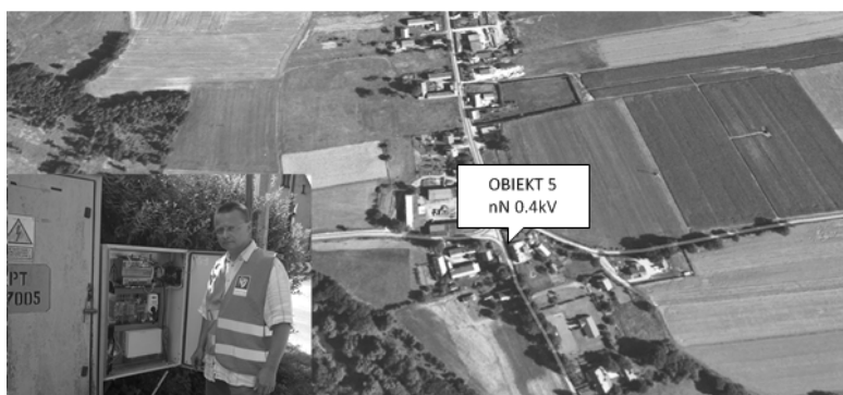
Rys. 2.5. Lokalizacja i realizacja układu pomiarowego parametrów JEE (OBIEKT 5) [3]
