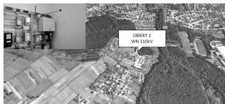
Rys. 2.2. Lokalizacja i realizacja układu pomiarowego parametrów JEE (OBIEKT 2) [3]
