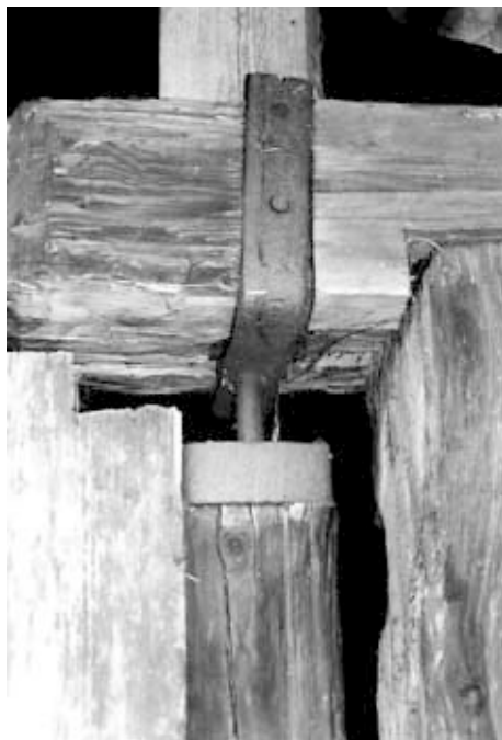
Ryc. 27. 1 – Biegun drewniany. Szopa na narzędzia, Kryry, fot. autora 2 – Biegun stalowy. Stodoła, Brześć, fot. autora
