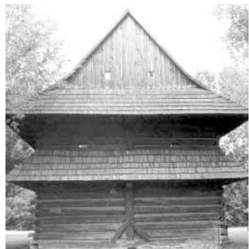
Ryc.15. Łątki w ścianie zrębowej. Spichlerz, Simoradz, obecnie w Górnośląskim Parku Etnograficznym, fot. autora
