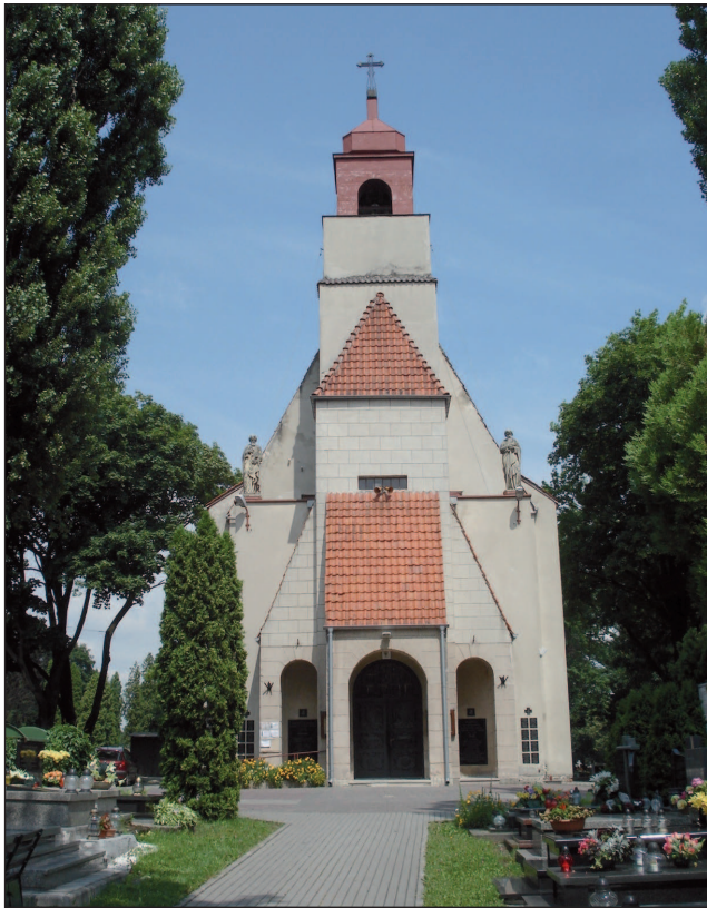
7. a) Kaplica na cmentarzu przy ul. Unickiej w Lublinie zaprojektowana przez A. Gruchalskiego, widok od frontu. Fot. J. Żywicki, 2014
