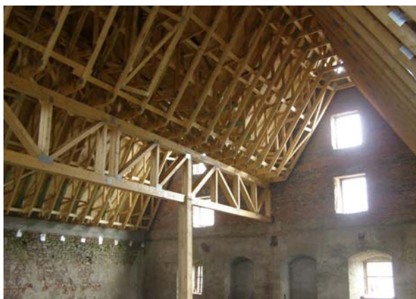
Ryc. 11. Więźba dachowa po montażu w ramach adaptacji spichlerza w grudniu 2014 r. (fot. Fundacja Odbudowy Dworu Sarny)
