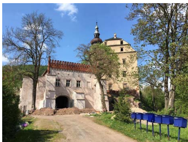
Ryc. 1. Dwór Sarny z odbudowanym krenelażem domu bramnego – widok od południowego zachodu (fot. Fundacja Odbudowy Dworu Sarny)
