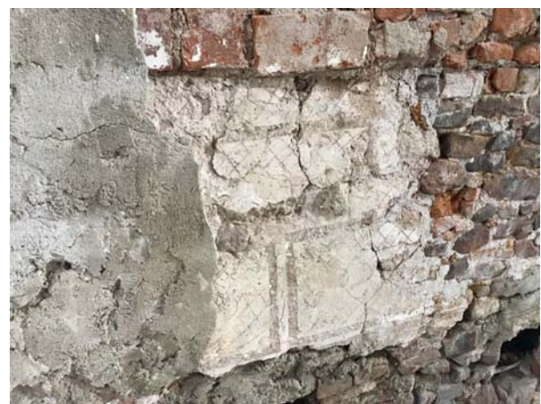
Ryc. 9. Sgraffito z XVIII wieku na wewnętrznej ścianie spichlerza (fot. Fundacja Odbudowy Dworu Sarny)
