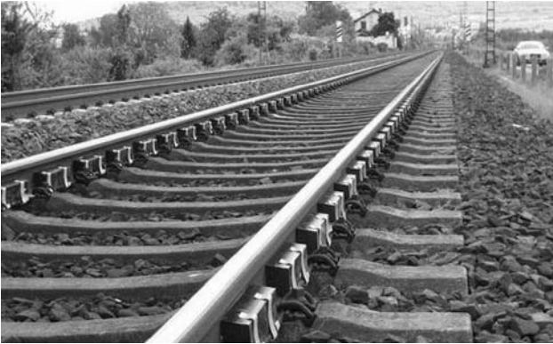
Rys. 3. Nakładki na szynach kolejowych [3]
