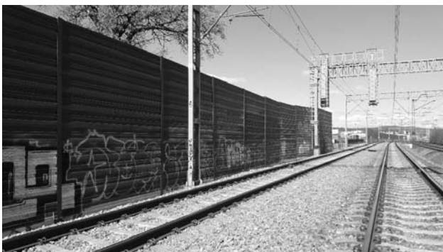
Rys. 2. Ekran akustyczny w Gdyni na linii kolejowej E65 Warszawa – Gdynia [fot. autor]
