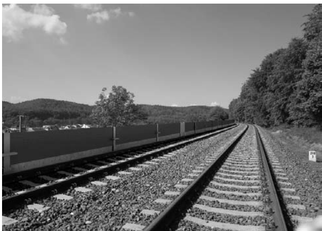
Rys. 8. Wizualizacja niskiego ekranu akustycznego w Gdyni na linii kolejowej 201 Gdynia – Kościerzyna [fot. autor]
