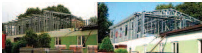
Rys. 3. Kolejne etapy nadbudowy, na przykładzie MPGK Rzeszów
