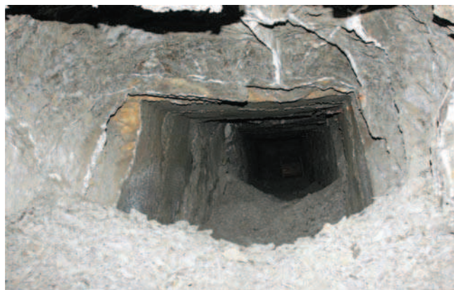
Rys. 4. Destrukcja ociosu północnego komory i chodnika w kierunku północnym, fot.: A. Maj [11]
