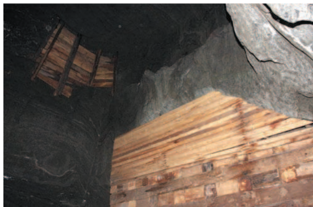
Rys. 3. Ocios wschodni, komora z półką solną podpartą obudową drewnianą, fot.: A. Maj [11]
