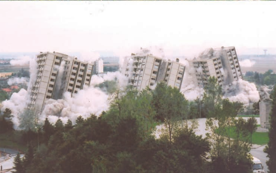
II. 5. Budowa, degradacja i wyburzenia w Vénissieux Minguettes / Construction, degradation and demolition, Vénissieux Minguettes. Source: Photos provided Clemence Beuret from Maison du Projet/Zdjęcia przekazane przez Clemence Beuret z Maison du Projet
