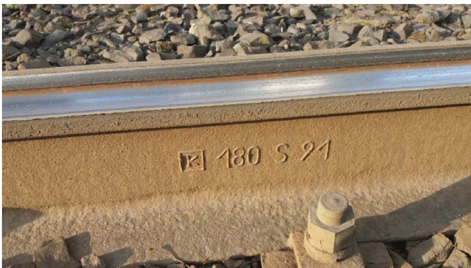
Rys. 8. Oznaczenia na eksploатовanej szynie tramwajowej 180 S wykonane podczas produkcji szyn przez producenta Hutę Katowice w 1991 r.; na powierzchniach bocznych główki, szyjki i stopki występuje tylko rdzawy nalot (zdjęcie wykonane w czerwcu 2017 r.)
