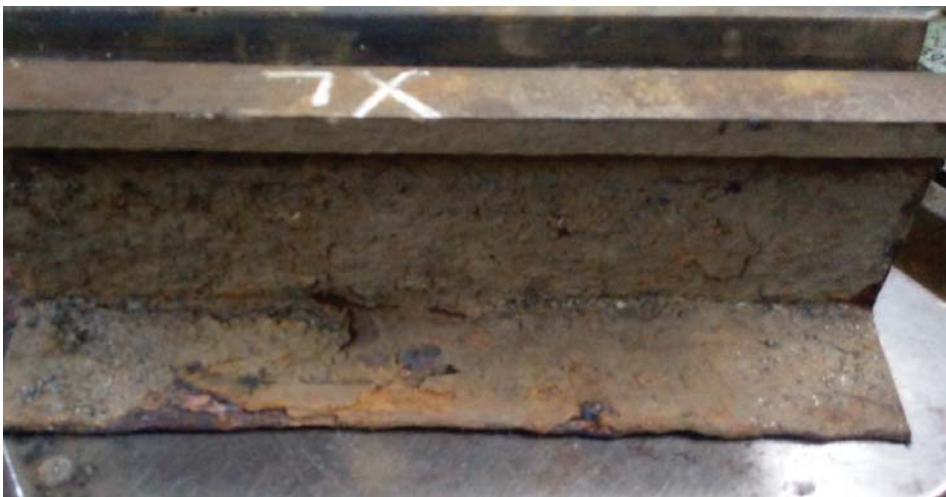
Rys. 11. Widok wycinka szyny ze strefy anodowej przed piaskowaniem, ułożonego na wadze; widoczne są wyraźne ubytki materiału na krawędzi stopki oraz nierówności powierzchni ścianki bocznej szyjki szyny jak i stopki; na powierzchniach trapezowych stopki widoczne również płyty warstw różnych materiałów
