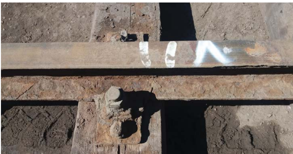
Rys. 14. Fragment szyny ze strefy katodowej wraz z mocowaniem do podkładu po procesie mechanicznego oczyszczenia z widocznymi śladami warstw nałożonych w procesie galwanicznego nanoszenia jonów elektrolitu glebowego, ale bez odsłoniętego materiału stopki szyny
