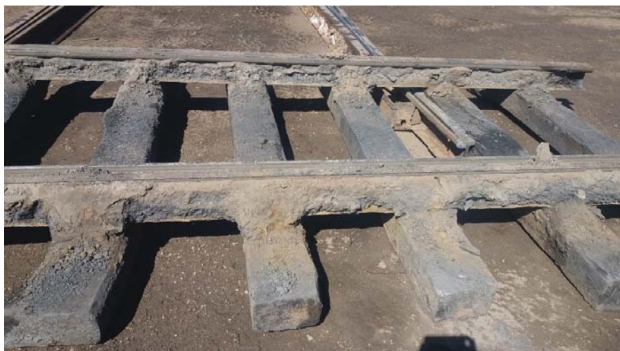
Rys. 9. Widok wzdłuż rusztu – górna fotografia i poprzecznie – dolna fotografia na zdemontowany ruszt torowy (przesło szynowe) po transporcie na plac rozbiórkowy; stan przed mechanicznym czyszczeniem
