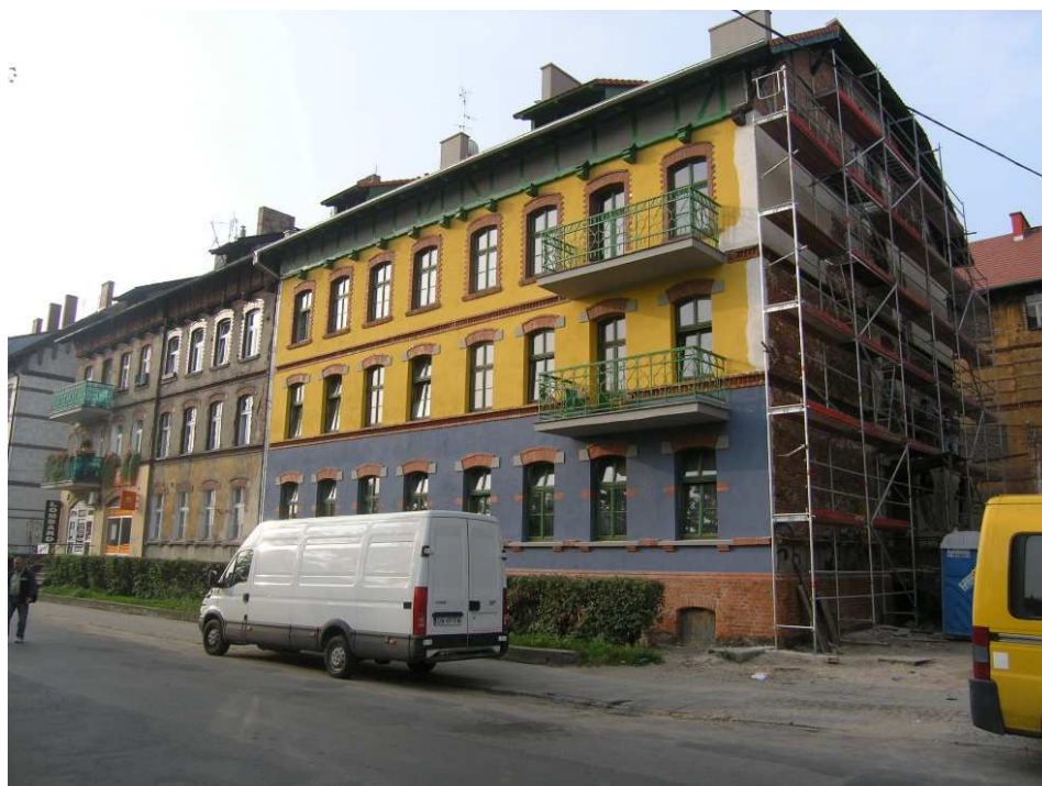
Rys. 3. Budynek Chińska 3A w trakcie prac, w głębi budynek 3B w stanie jak budynek 3A przed podjęciem prac, fot. autor
