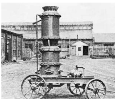
Rys. 3. Metoda mokra torkretowania
