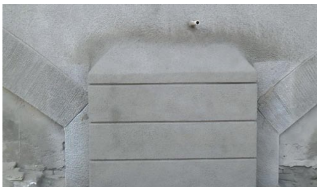
Rys. 5. Torkret architektoniczny i naprawczy; fragment estakady
