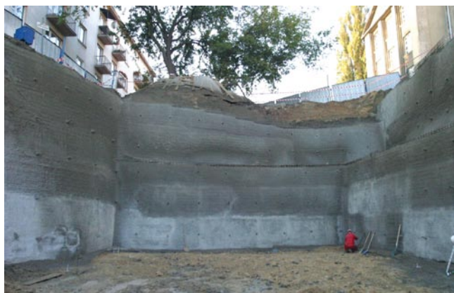
Rys. 6. Przykład wzmocnienia wykopu pod „plombę” budowlaną
