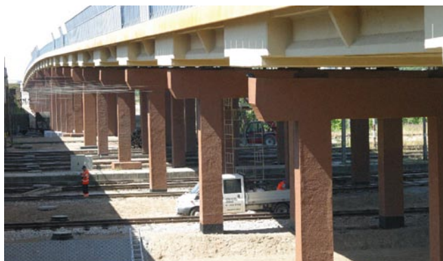
Rys. 8. Ustrój nośny wiaduktu Franowo w Poznaniu, lata 2008–2009
