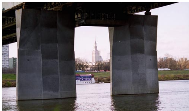
Rys. 7. Podpory Mostu Łazienkowskiego, lata 2002–2003
