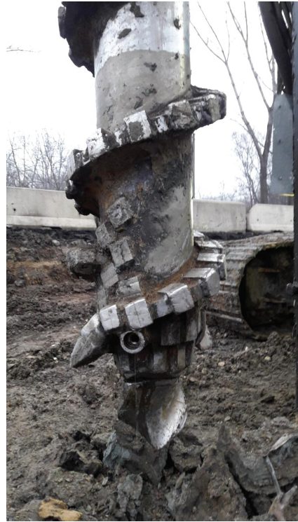
Rys. 5.2. Świder IMB Injection Displacement Pile (w skrócie IMBDP) – widok dyszy iniekcyjnej [10]
