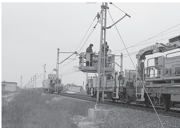
Fot. 10. Demontaż kotwienia krańcowego, rozpoczęcie procesu zwijania sieci
