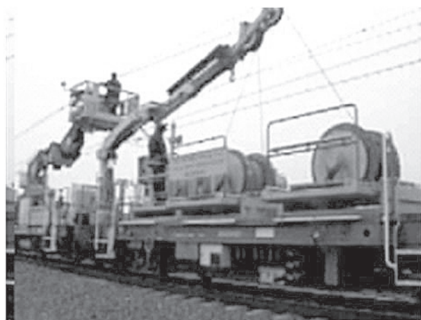
Fot. 12. Proces zwijania sieci trakcyjnej
