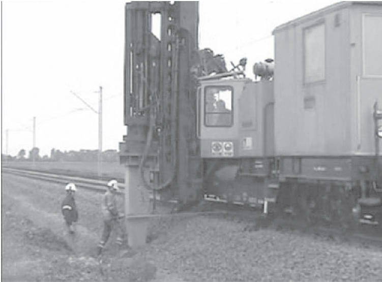
Fot. 2. Zabijanie w gruncie fundamentu palowego
