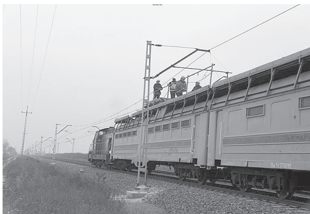
Fot. 11. Likwidacja wieszaków i połączeń elektrycznych
