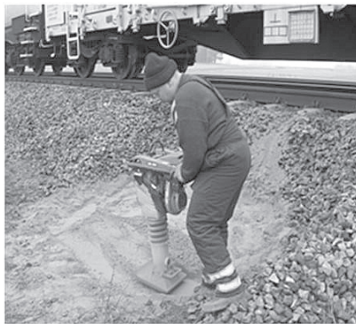
Fot. 15. Zagęszczanie
