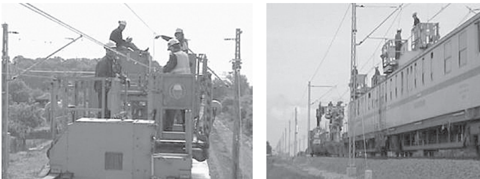
Fot. 8 i 9. Platformy robocze zamontowane na zestawie PWST
