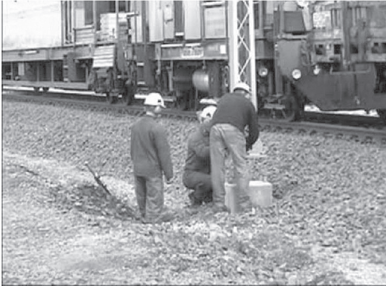
Fot. 1. Osadzanie i przytwierdzanie konstrukcji wsporczej do fundamentu palowego
