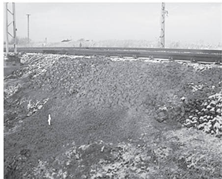
Fot. 16. Ława po odbudowie
