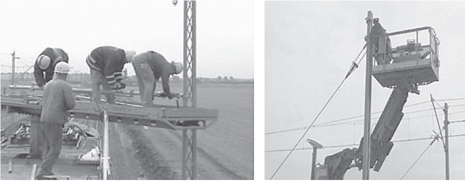
Fot. 4 i 5. Pomost i platforma robocza umieszczona na wysięgniku żurawia zestawu PWST
