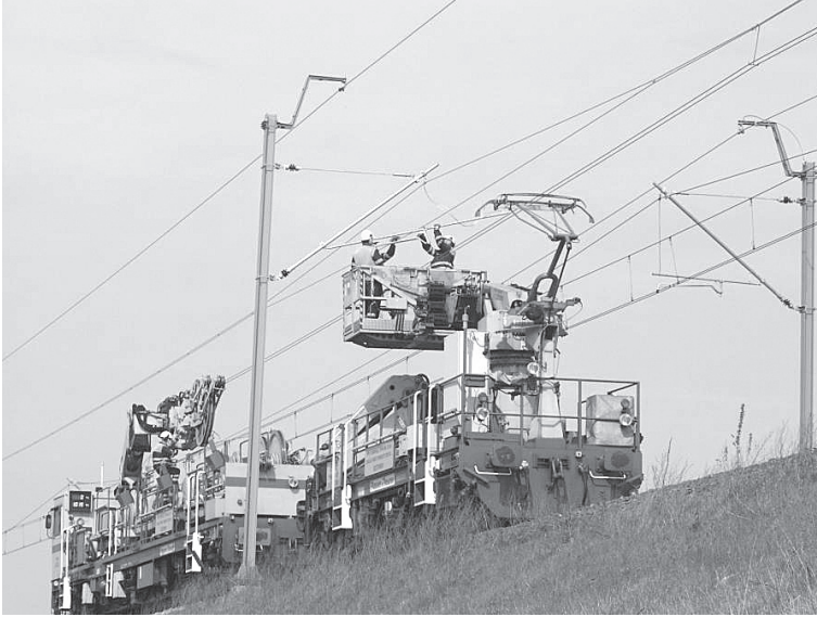
Fot. 3. Pociąg PWST na linii CMK
