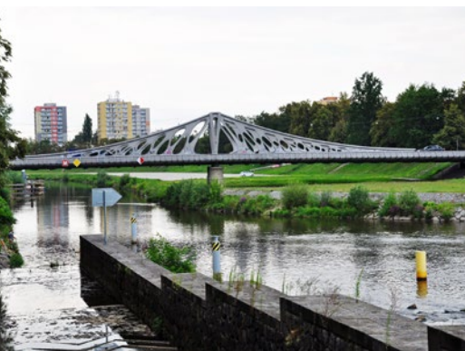
Stalowy most wspornikowy przez Wełtawę (obiekt nr 40)
