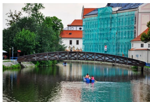
Drewniana kładka dla pieszych przez Małšę (obiekt nr 37)
