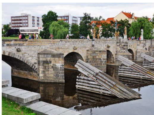
Izbicka obiektu nr 34 w Pisku
