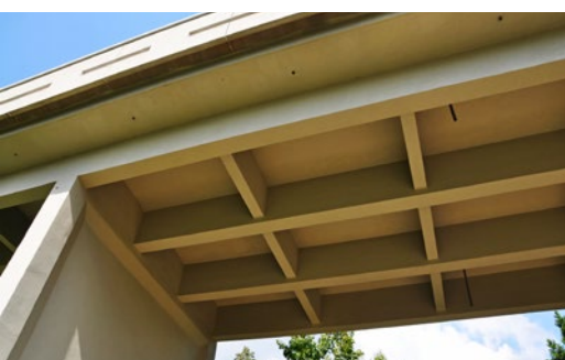
Pomost mostu ramowego w przedłużeniu obiektu nr 29 (obiekt nr 30)
