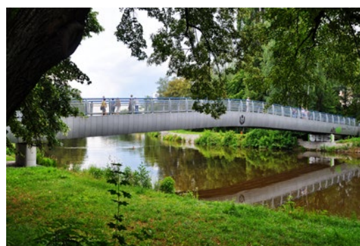
Stalowa kładka dla pieszych przez Wełtawę (obiekt nr 38)
