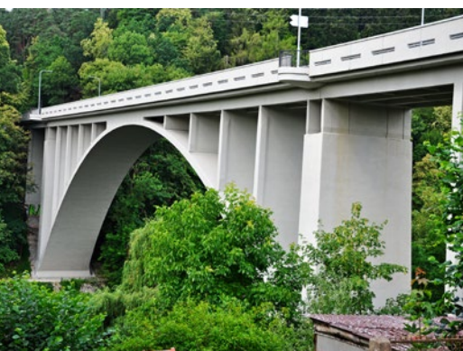
Żelbetowy most łukowy z jazdą górą (obiekt nr 29)
