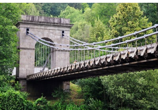
Drewniany pomost obiektu nr 32 w Stádlcu
