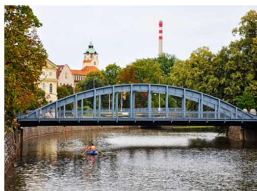
Stalowy most łukowy z jazdą dołem przez Małšę (obiekt nr 36)
