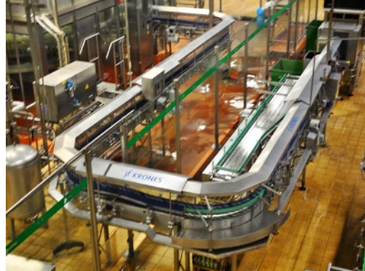
Widok hali produkcyjnej browaru Prazdroj
