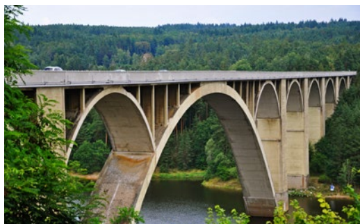
Żelbetowy, łukowy most drogowy z jazdą górą przez Wełtawę (obiekt nr 33)
