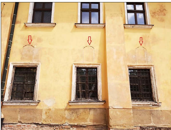
Ryc. 7. Elewacja budynku z salą z polichromią, oznaczono starsze, mniejsze otwory w zewnętrznej, starszej warstwie ściany, 2019; fot. A. Bojęś-Białasik.
