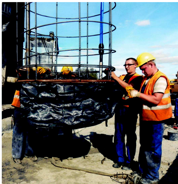
Rys. 6. Etapy instalowania na dolnym końcu szkieletu zbrojeniowego urządzenia Politechniki Gdańskiej do rozprowadzania iniektu pod stopą pała. Budowa mostu autostradowego przez Wisłę w Grudziądzu [fot. A. Jarominiak]
