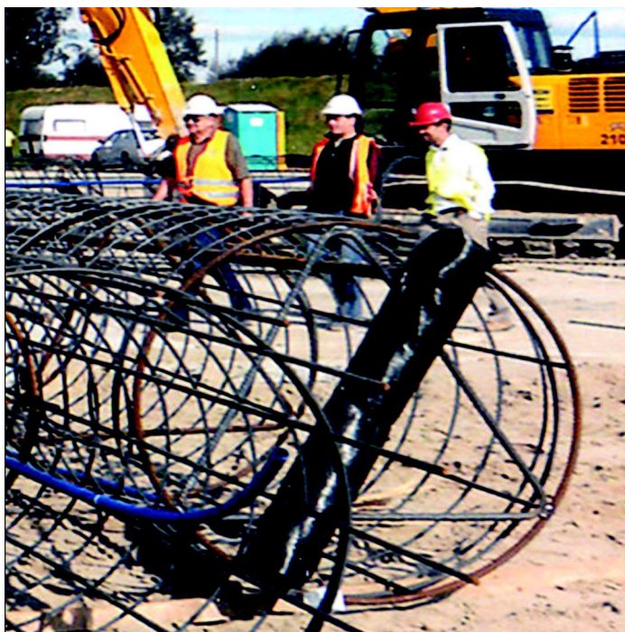
Rys. 6. Etapy instalowania na dolnym końcu szkieletu zbrojeniowego urządzenia Politechniki Gdańskiej do rozprowadzania iniektu pod stopą pała. Budowa mostu autostradowego przez Wisłę w Grudziądzu [fot. A. Jarominiak]
