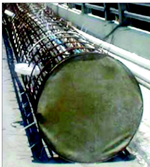
Rys. 5. Płaski siłownik iniekcyjny: z lewej – widok ogólny [3], z prawej – widok membrany zamykającej siłownik od dołu [8]
