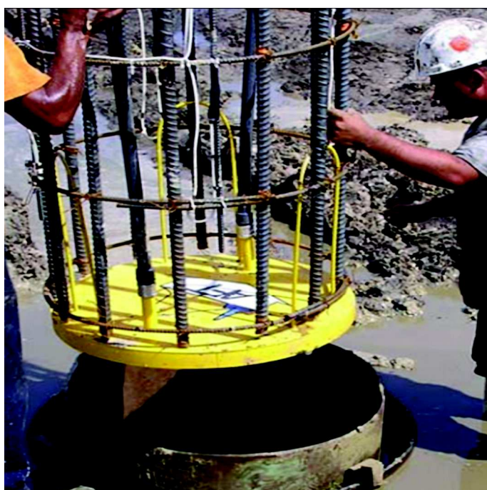
Rys. 5. Płaski siłownik iniekcyjny: z lewej – widok ogólny [3], z prawej – widok membrany zamykającej siłownik od dołu [8]
