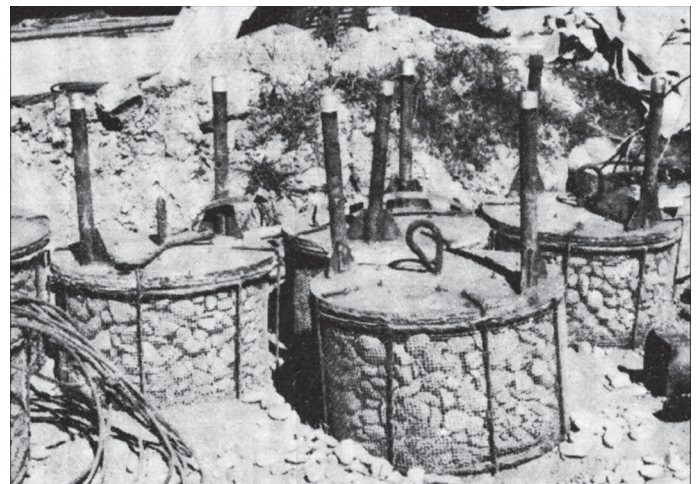
Rys. 3. Kosze wypełnione otoczkami użyte do rozprowadzania iniektu pod stopami pali pylonów mostu podwieszanego Chaco/Corrientes przez Paranę w Argentynie. Pale mają średnicę 1,8 m, długość 48 m, z tego 27 m w gruncie poniżej dna rzeki o głębokości 21 m. Kosz opuszczano na dno otworu pala przed osadzeniem w nim szkieletu zbrojeniowego [World Construction, March, 1974]
