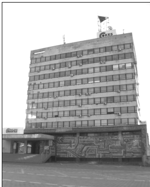
Fot. 6. Budynek ZEG-u z oryginalną mozaiką obwodów scalonych. Photo 6. ZEG Building with Original Integrated Circuit Mosaics.
