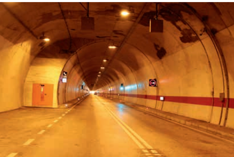
Tunel drogowy, fot. nbi media
