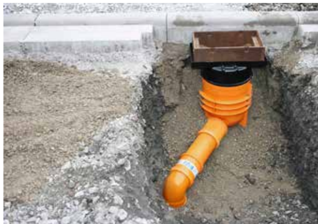
Wpust uliczny RainSpot po zamontowaniu
