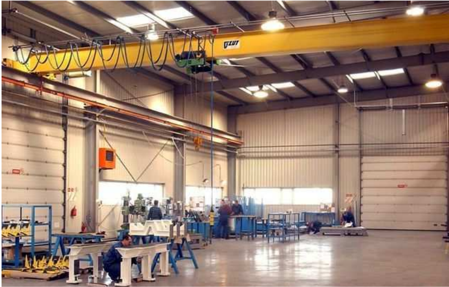
Rys. 1. Przemysłowa hala stalowa z transportem wewnętrznym [2]
