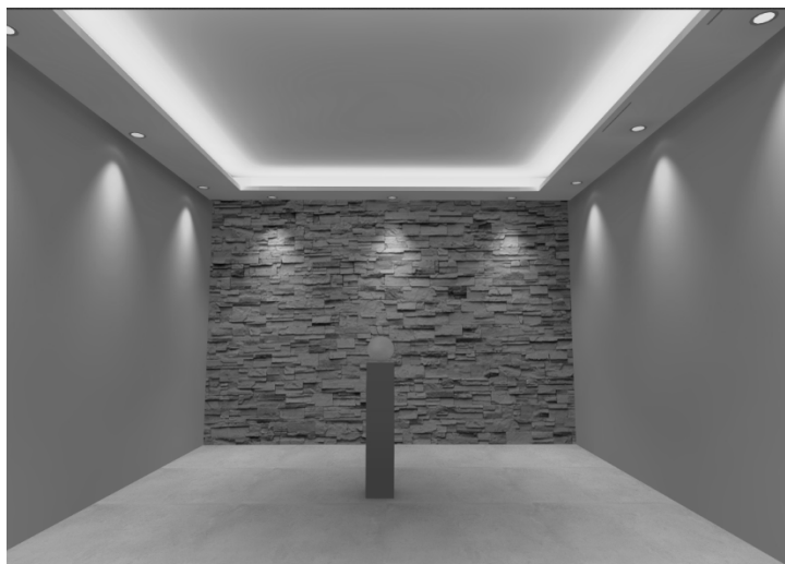
Rys. 6. Oświetlenie wnętrza punktowymi oprawami. Podświetlony sufit
