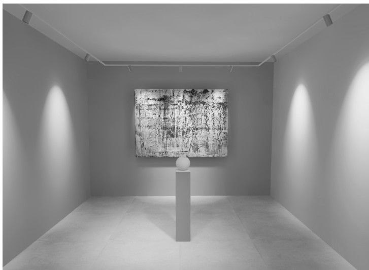
Rys. 9. Akcentujące oświetlenie wszystkich ścian wnętrza
