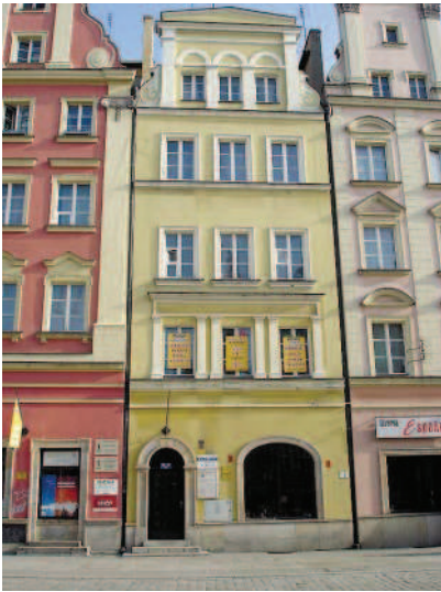
Ryc. 13. Rażąca biała kolorystyka ram okiennych oraz nieuzasadniona redukcja detali architektonicznego wystroju kamienicy nr 56/57 przy wrocławskim Rynku w pierzei płn. (fot. autor)
