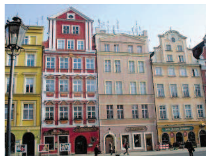
Ryc. 11. Pierzeja płn. wrocławskiego Rynku (kamienice nr 44-47) – stan obecny ze zredukowanymi elementami architektonicznego wystroju (fot. autor)
