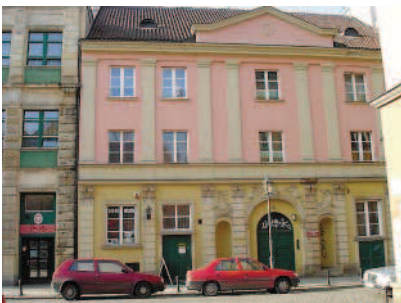
Ryc. 15. Wrocław, ul. Ofiar Oświęcimskich 3 – kamienica XVII-wieczna – 2. i 3. kondygnacja pozbawione w linii otworów okiennych architektonicznego wystroju – opasek okiennych, fartuchów, naczółków (fot. autor)
