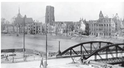
Ryc. 3. Zespół zabudowy Ostrowa Tumskiego – widok strony południowej (fot. arch.)
