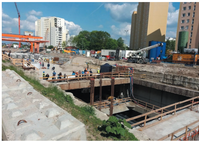
Fot. 2. Budowa stacji metra Targówek Mieszkaniowy w 2017 roku Źródło: opracowanie własne
